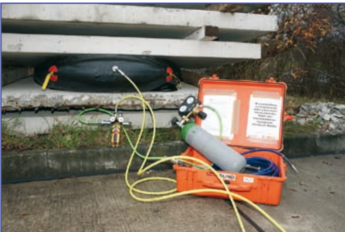
Die Hebekissen im Einsatz
