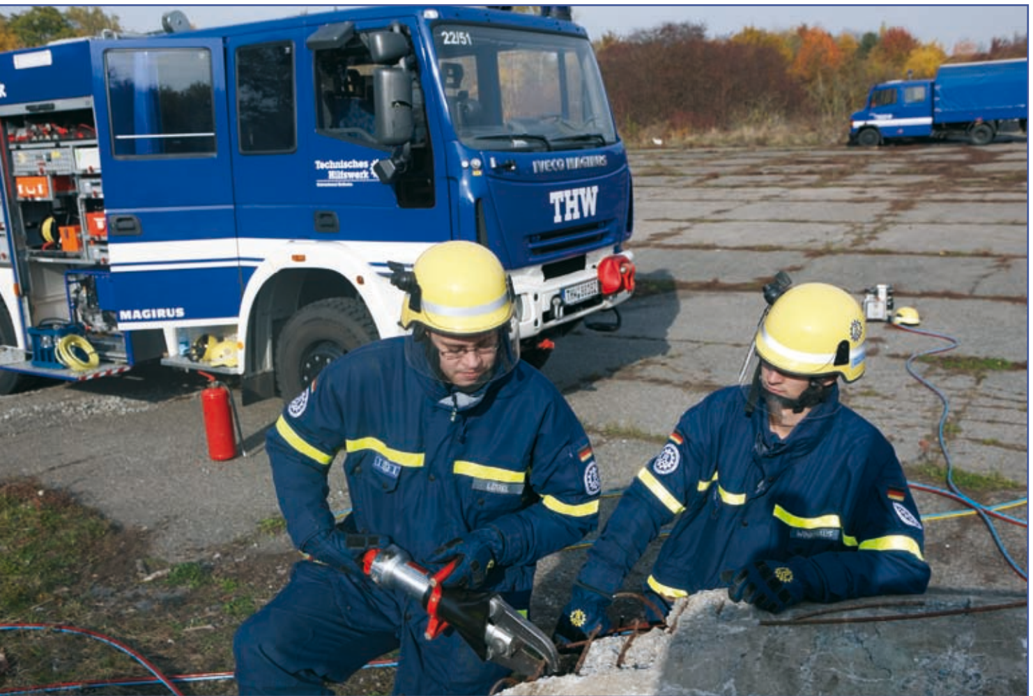
Die hydraulische Schere im Einsatz an einem Betonrohr mit Bewehrung
