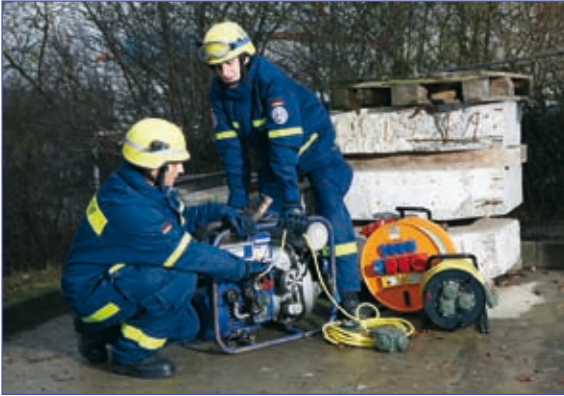
Der Stromerzeuger 5 kVA wird aufgebaut
